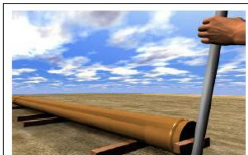
Fig. 05 - Havendo dificuldade no encaixe recomenda-se a utilização de uma alavanca na sua conexão. Neste caso, a bolsa do tubo deverá ser protegida do contato com a alavanca com uma peça de madeira.
