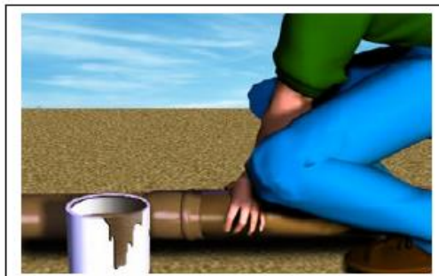
Fig. 04 - Conexão dos tubos A ponta do tubo (tubo macho) será introduzida até o fundo da bolsa do outro tubo.
