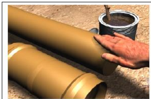
Fig. 10 - Aplicação da pasta lubrificante
