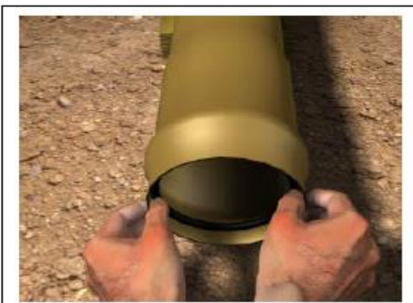
Fig. 02 - Introdução do anel de borracha O anel de borracha será introduzido no sulco da bolsa.
