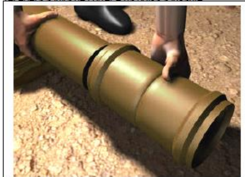
Fig. 11 - Montagem de luva de correr
