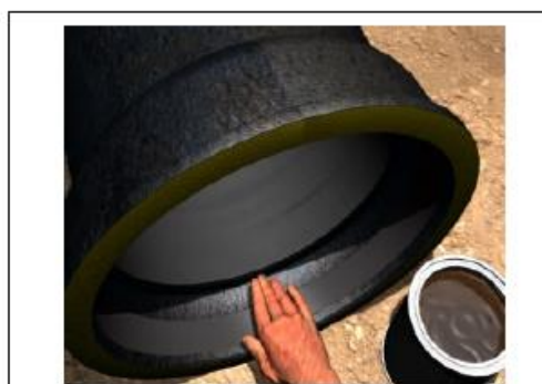
Fig. 07 - Aplicação do lubrificante O lubrificante deverá ser aplicado sobre o anel de borracha e sobre a ponta do tubo, até aproximadamente 2 cm da marca de giz.
