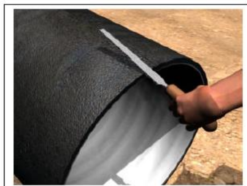
Fig. 04 - Preparação das pontas O chanfro na ponta do tubo deverá ser verificado para que não danifique o anel de borracha durante a montagem
