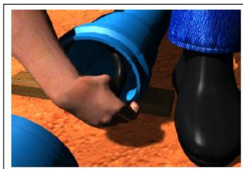
Fig. 02 - Introdução do anel de borracha O anel de borracha será introduzido no sulco da bolsa.
