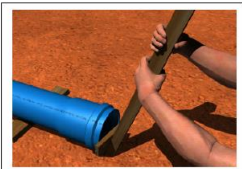
Fig. 05 - Havendo dificuldade no encaixe, recomenda-se a utilização de uma alavanca. Neste caso, a bolsa deverá ser protegida do contato com a alavanca, utilizando-se uma peça de madeira
