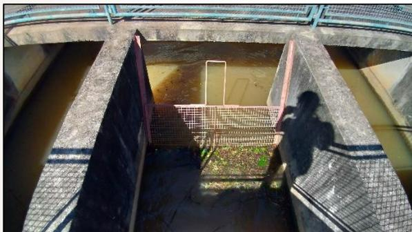
Figura 21 – Sistema de Gradeamento
