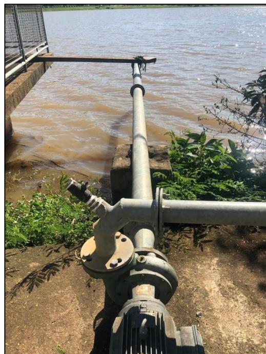
Figura 22 – Tubulação pra captação de água bruta para abastecimento de caminhões pipa
