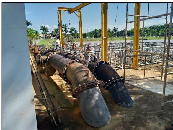
Figura 20 – A esquerda tubulação de adução tratada e a direita de água bruta
