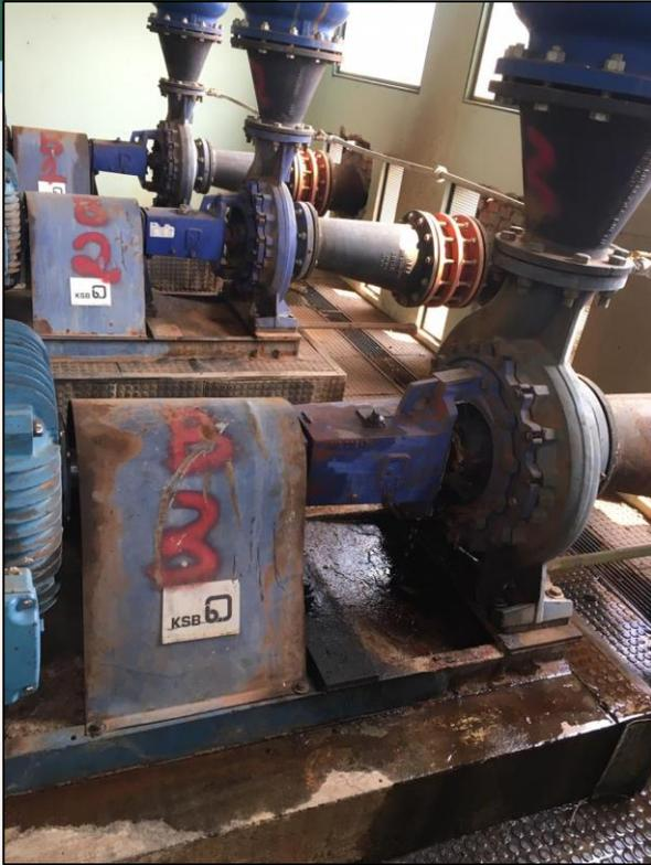
Figura 46 – Vazamentos nas bombas de captação
