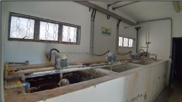
Figura 30 – Tanques de Cal Hidratada
