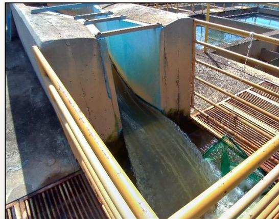
Figura 27 – Calha Parshall direcionando a água para os floculadores
