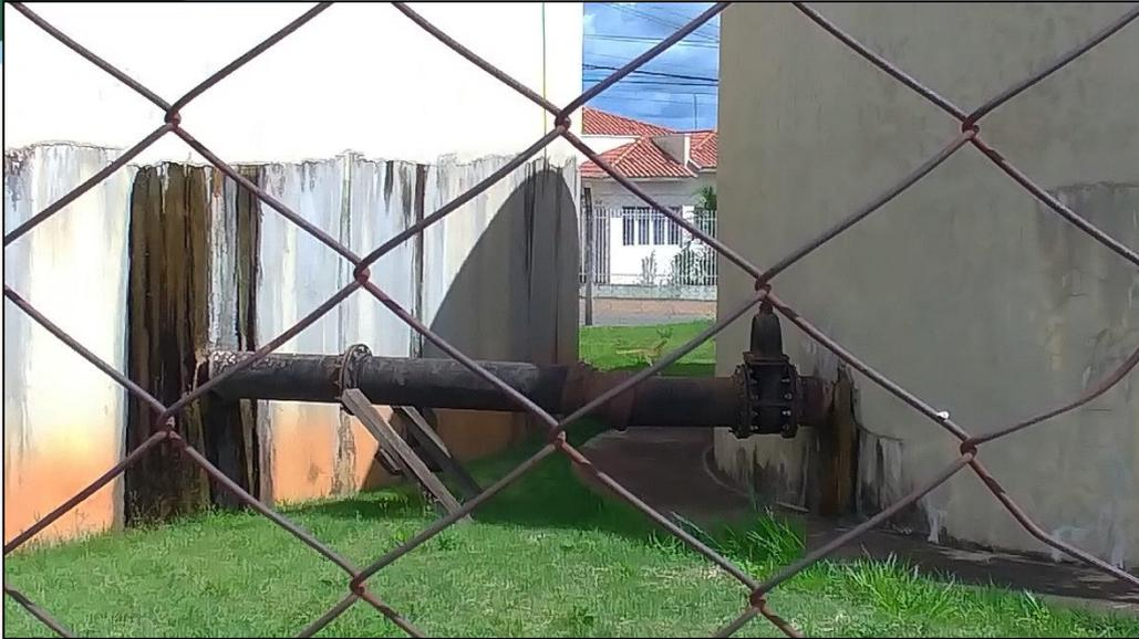
Figura 44 - Reservatórios Jardim Paulista interligados, com vazamentos visíveis.
