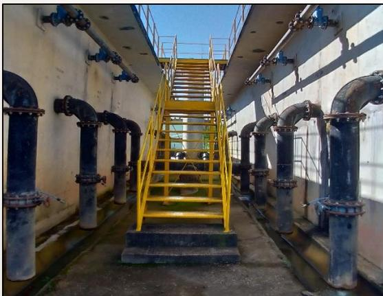
Figura 34 – Células de tratamento e vista dos dutos de descarte de água de lavagem dos filtros e decantadores.
