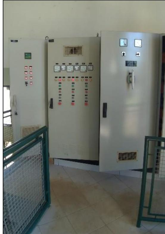
Figura 47 – Painéis elétricos das bombas
