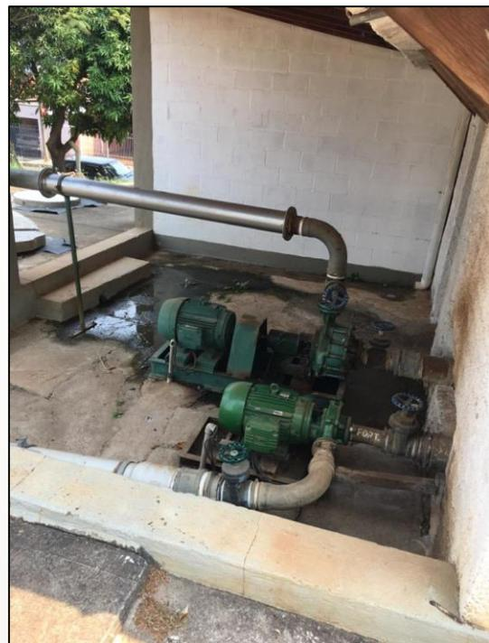
Figura 55 – Bombas apresentando vazamentos
