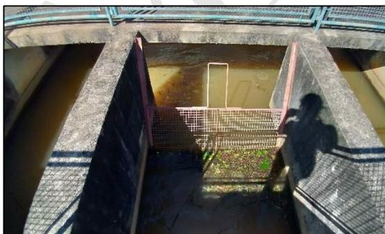
Figura 17 – Sistema de Gradeamento
