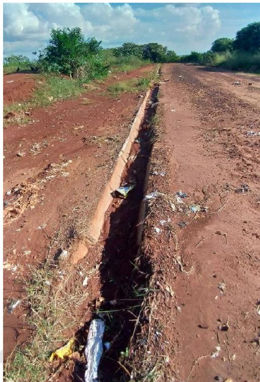
Figura 133 – Canaletas de drenagem pluvial.
