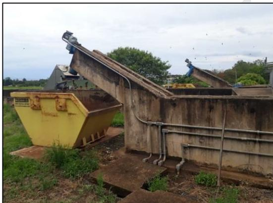
Figura 103 – Descarte de lodo dos adensadores.
