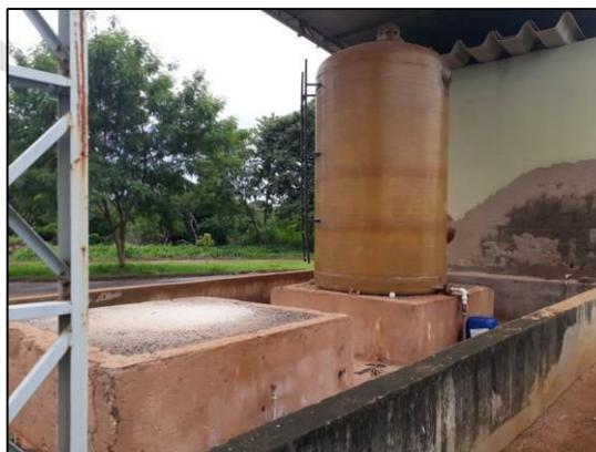
Figura 112 – Reservatório de hipoclorito de sódio com tanque de contenção.
