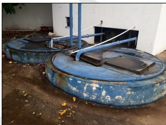
Figura 67 – Poços de sucção de esgoto da EEE Verona
