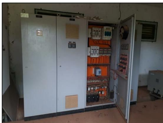
Figura 94 – Painéis elétricos da bomba da EEAT de esgoto da ETE.
