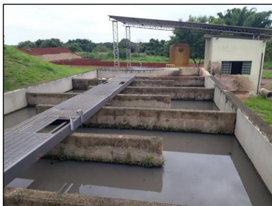
Figura 114 – Tanque de contato.
