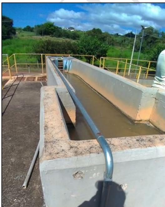
Figura 22 – Vista da entrada de água bruta na ETA
