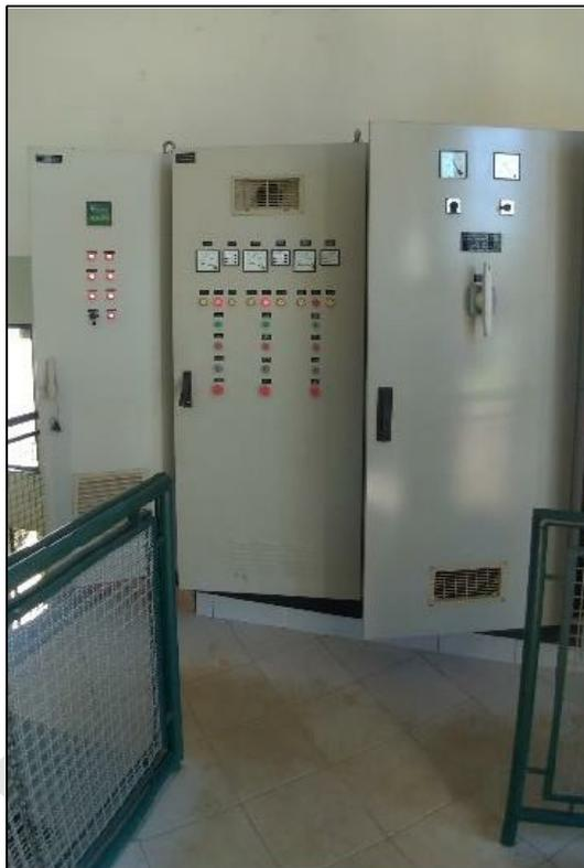
Figura 34 – Painéis elétricos das bombas
