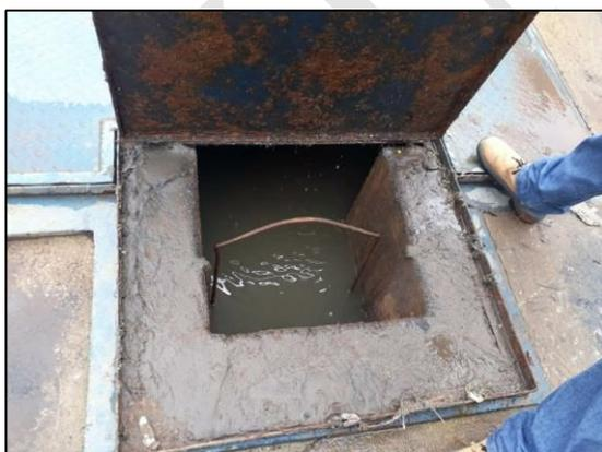
Figura 68 – Gradeamento da EEE Verona que encontrava-se sobrecarregado
