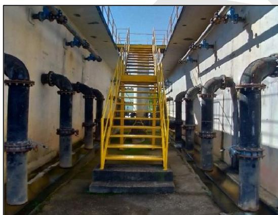
Figura 30 – Células de tratamento e vista dos dutos de descarte de água de lavagem dos filtros e decantadores.
