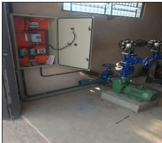
Figura 87 – Bombas e painel elétrico da EEE Vila Esperança
