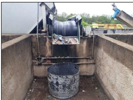
Figura 97 – Esteira de coleta de resíduos retidos no gradeamento
