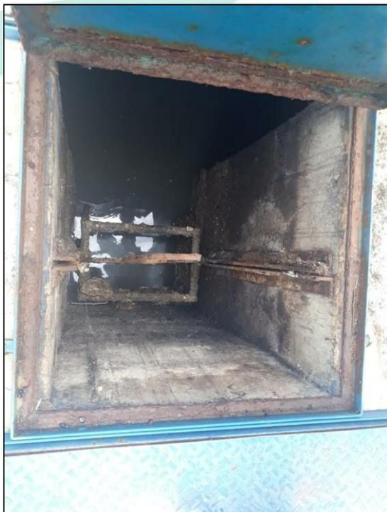
Figura 86 – Gradeamento da EEE Canaã
