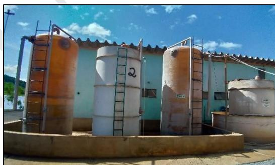
Figura 27 – Três tanques de armazenamento de sulfato de alumínio e tanque de armazenamento de ácido fluorsilícico da esquerda para a direita, respectivamente.
