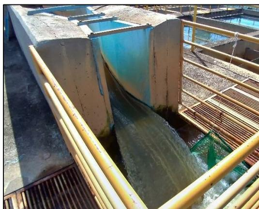
Figura 23 – Calha *Parshall* direcionando a água para os floculadores
