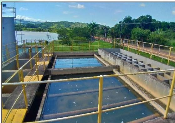
Figura 24 – Vista de cima de uma das células de tratamento da ETA.
