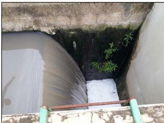
Figura 115 – Degrau de aeração no final do tanque de contato.
