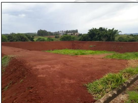
Figura 111 – Leito de secagem de lodo
