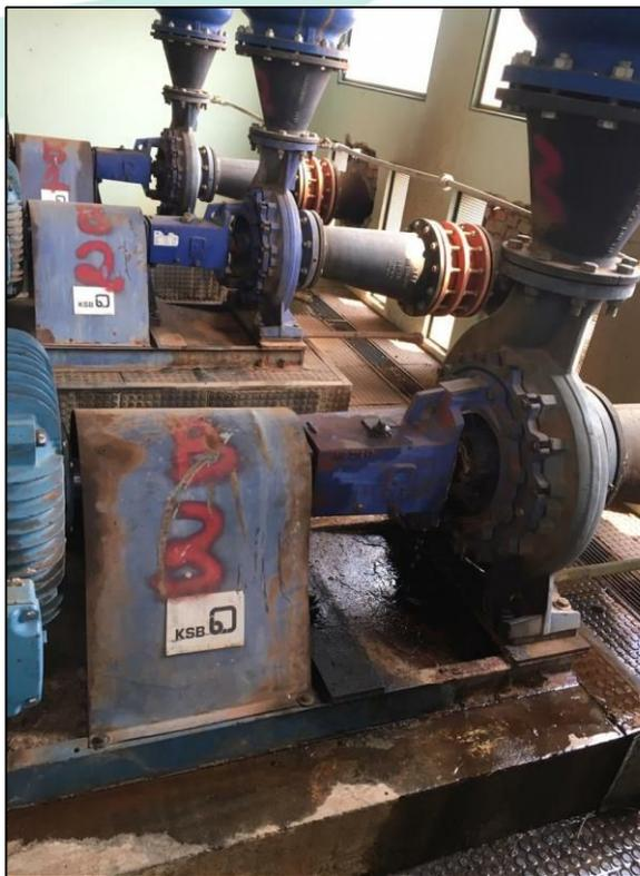
Figura 33 – Vazamentos nas bombas de captação
