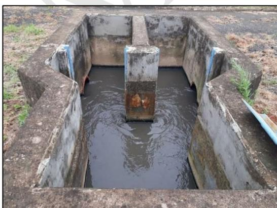
Figura 105 – Caixa divisória de esgoto para as lagoas aeradas.
