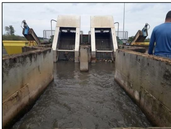
Figura 96 – Caixa de areia e gradeamento de resíduos finos mecanizado
