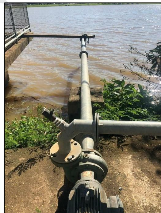
Figura 18 – Tubulação pra captação de água bruta para abastecimento de caminhões pipa
