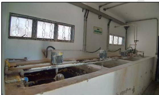
Figura 26 – Tanques de Cal Hidratada
