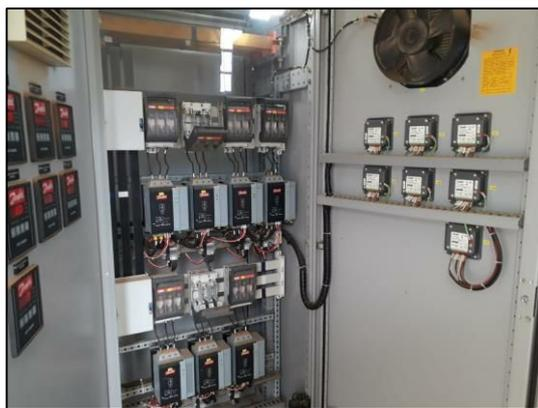
Figura 108 – Painel elétrico dos aeradores.
