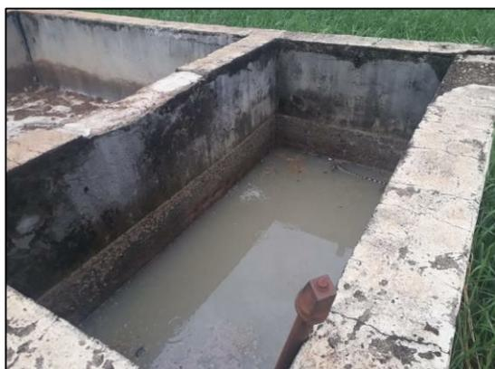
Figura 76 – Módulo de gradeamento da EEE Distrito Industrial
