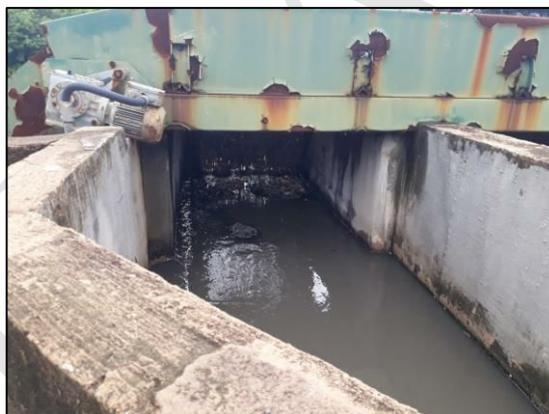
Figura 98 – Passagem de água após o gradeamento.
