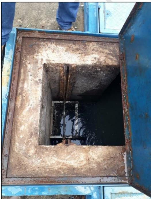
Figura 62- Sistema de gradeamento da EEE Cardoso
