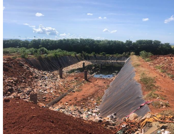
Figura 54 - Vala do Aterro Fonte: Amplar Engenharia
