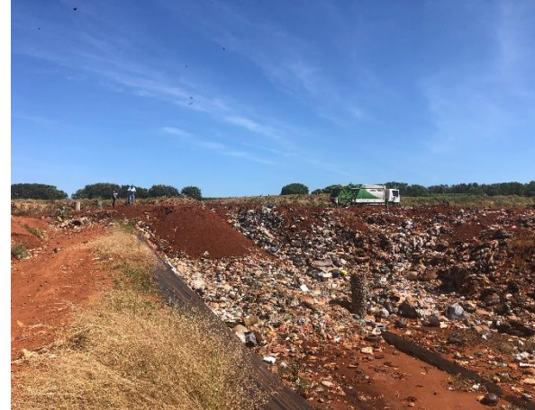
Figura 56 - Vala do Aterro Fonte: Amplar Engenharia
