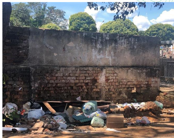
Figura 49 - Resíduos descartados de forma irregular em uma das entradas do Cemitério da Saudade Fonte: Amplar Engenharia
