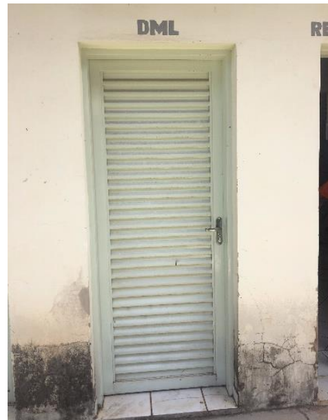
Figura 22 - Separação interna dos resíduos no Hospital Fonte: Amplar Engenharia
