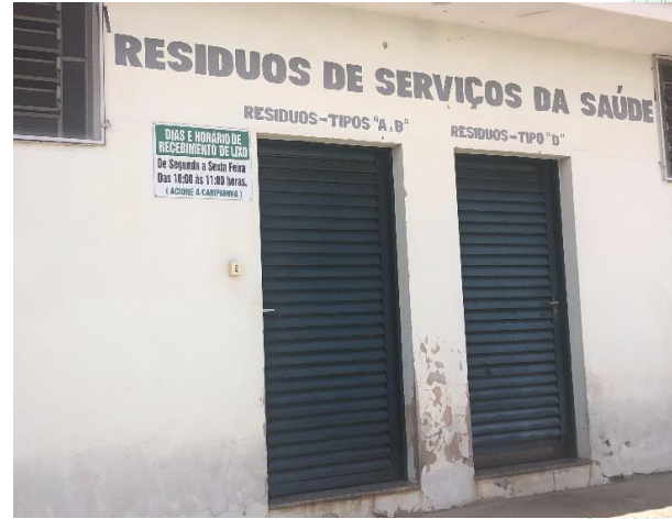
Figura 26 - Acesso externo para a coleta dos resíduos do Hospital Fonte: Amplar Engenharia
