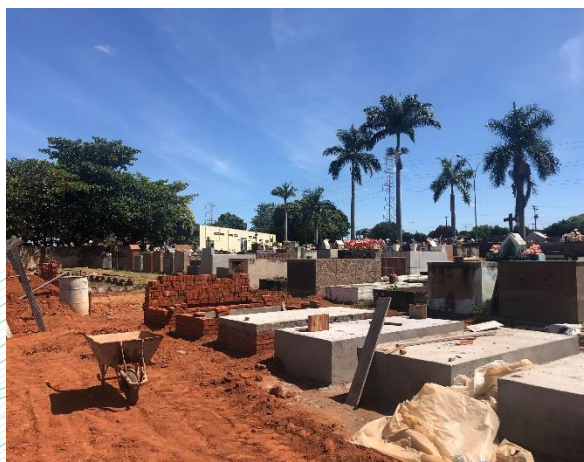
Figura 50 - Reforma e ampliação do Cemitério Parque das Acácias Fonte: Amplar Engenharia
