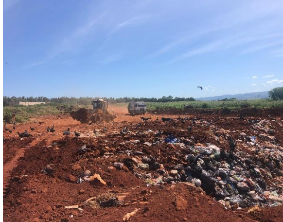
Figura 53 - Entrada do caminhão da coleta de resíduos Fonte: Amplar Engenharia
