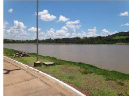
Foto 4.1 – Vista Geral da Represa do Rio Verde
