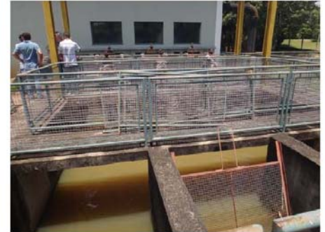
Foto 4.2 – Tomada de Água na Captação
