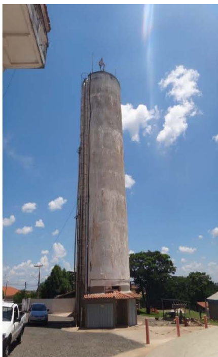
Foto 4.5 - Reservatório Elevado - Centro de Reservação
