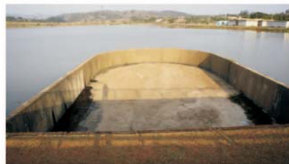
Nível da barragem de Vargem está abaixo do bico de pato.
