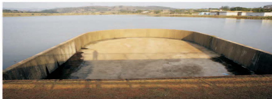
Nível da barragem de Vargem está abaixo do bico de pato.
